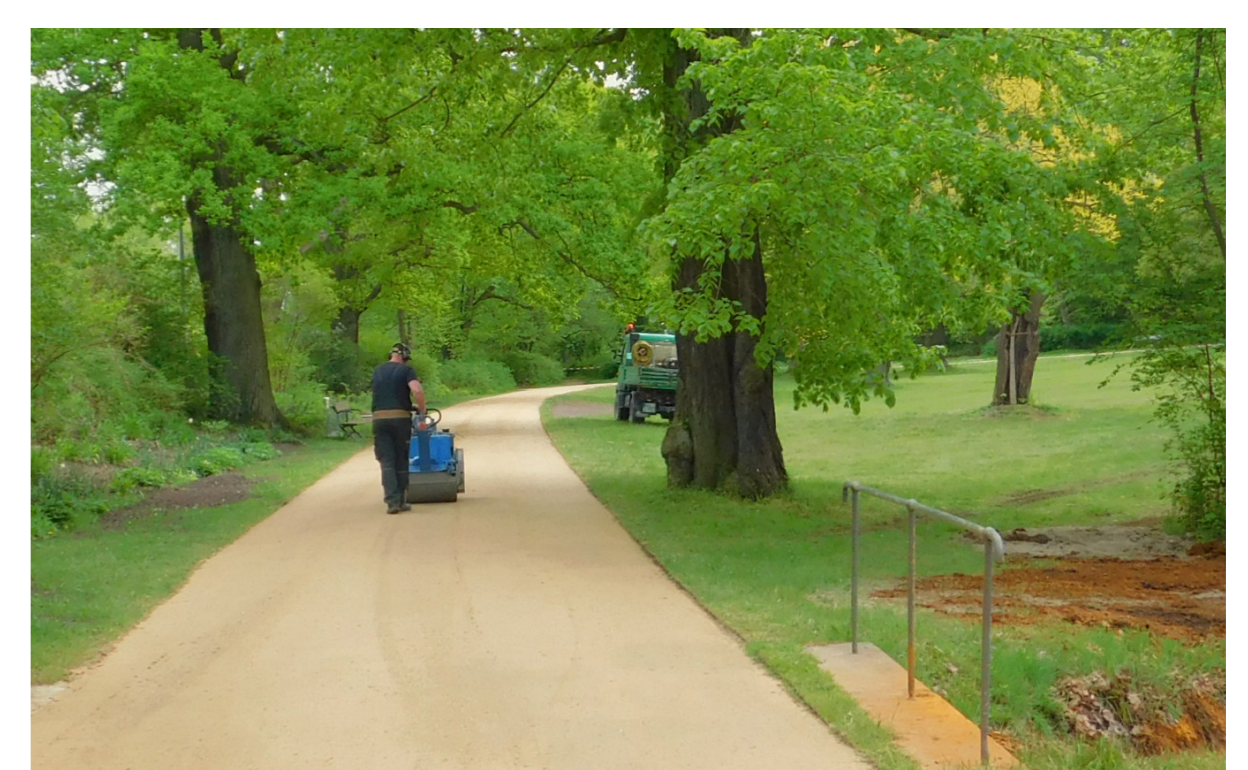
Wegebauarbeiten im Badepark mit der Walze. (Foto: H. Daetz)
