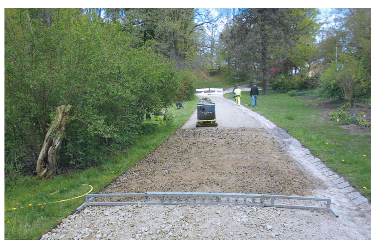
Wegebauarbeiten im Badepark. (Foto: B. Witzmann)
