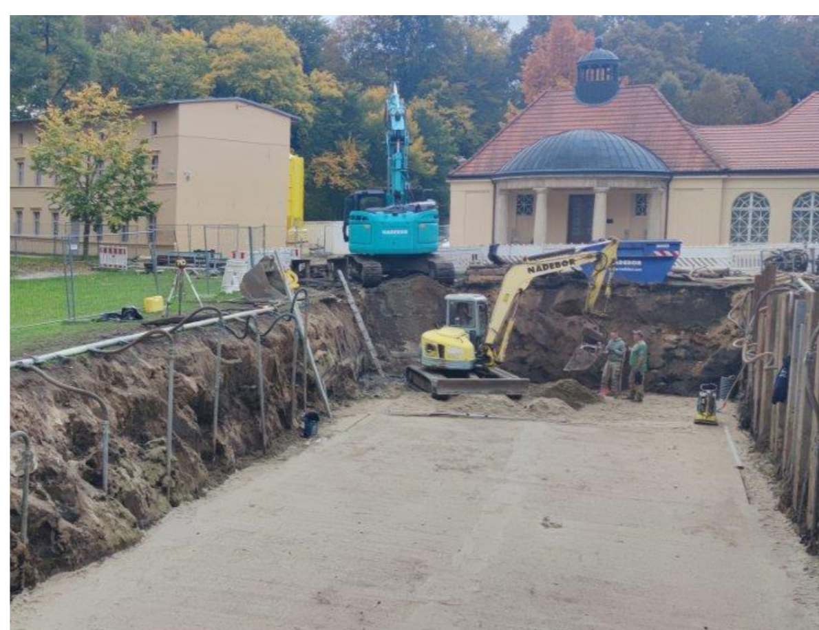
Bau der Zisterne im Badepark. (Foto: Büro Herold und Lorenz, Dresden)
