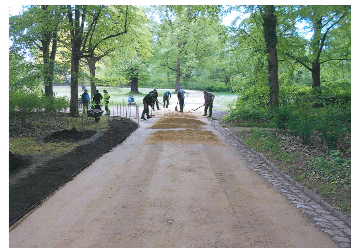
Wegebauarbeiten im Badepark. Auftragen der Deckschicht. (Foto: B. Witzmann)
