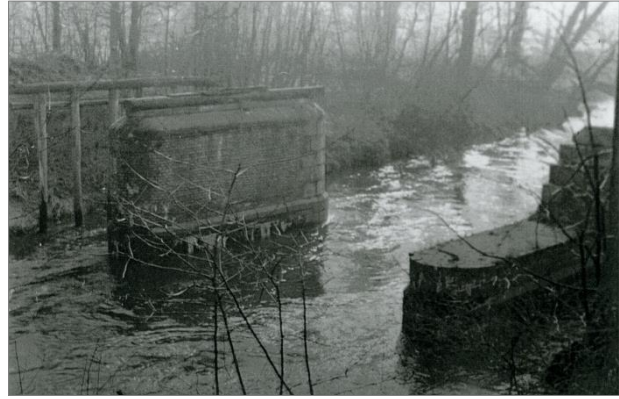
Abb. 9: Verbliebene Pfeiler der Doppelbrücke, Ende der 1940er Jahre (Sammlung Hans Schmidt, Bad Muskau).
