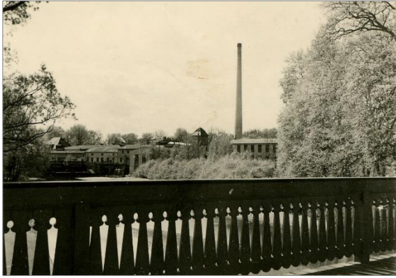
Abb. 8: Nach dem Hochwasser von 1897 errichtete Brüstung der Doppelbrücke, Anfang der 1940er Jahre (Sammlung Holger Klein, Bad Muskau).
