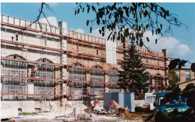
Im Jahr 1993 war endlich eine Sanierung möglich.
