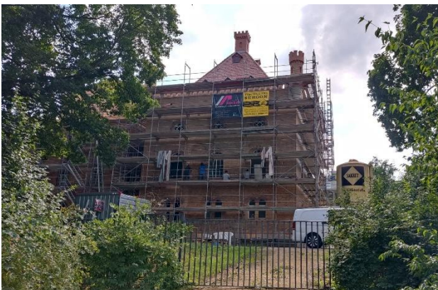
Am „Niederländischen Hof“ wird noch gebaut. Alte Abbildungen dienen dabei als Vorbild.
