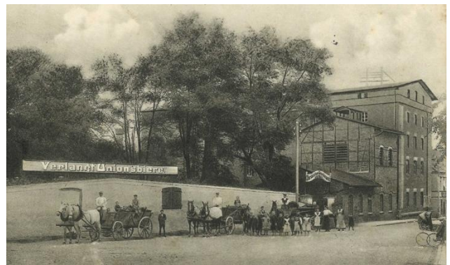
Blick von der Straße auf das große Brauhaus (rechts), um 1910. Hinter der hellen Wand im Vordergrund befand sich der Eiskeller.
