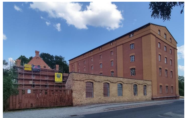
Das Brauhaus (rechts) ist außen schon fertig saniert. Im Inneren sind noch Bauarbeiten nötig.
