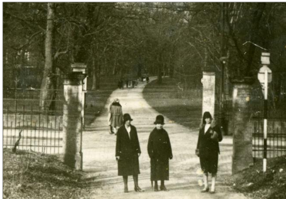
Abb. 18: Torpfeiler am Verbindungsweg/Oberweg um 1920, Blick aus Richtung Bergpark (Ausschnitt aus einer Fotografie, Original: Holger Klein, Bad Muskau).
