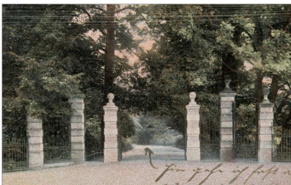
Abb. 15: Toranlage am Neißedamm nach der Erweiterung im Jahre 1901 oder 1902 (Ausschnitt aus einer historischen Ansichtskarte, Original: Sammlung der Stadt Bad Muskau).
